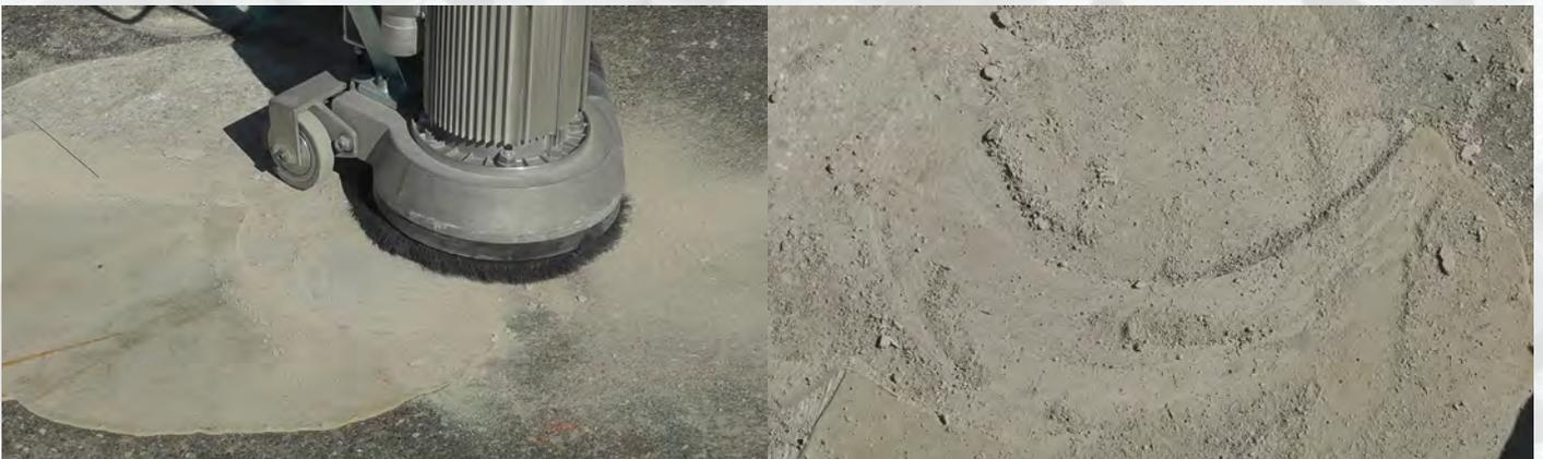
PKD Fünf-Segmente 250 NT: Abfräsen hochkunststoffvergüteter, faserarmerter Spachtelmasse
