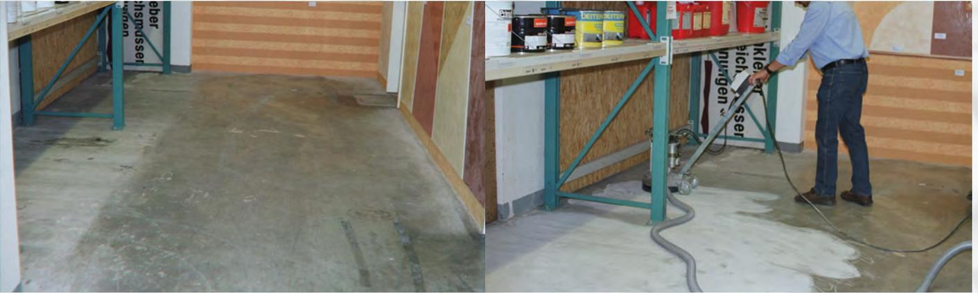
Diamantfräuscheibe 250 NT für Beton: Abschleifen einer 1k-Altbeschichtung von einem Lagerboden
