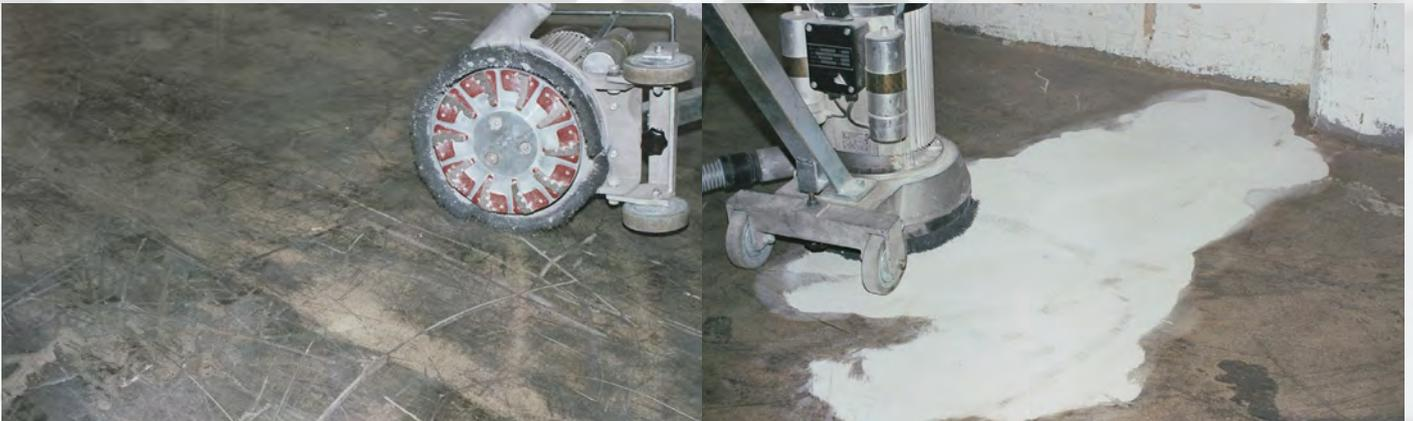
Diamantfrässcheibe 250 NT rot abrasiv: Anschleifen einer mechanisch hoch beanspruchten Epoxidharzbeschichtung
