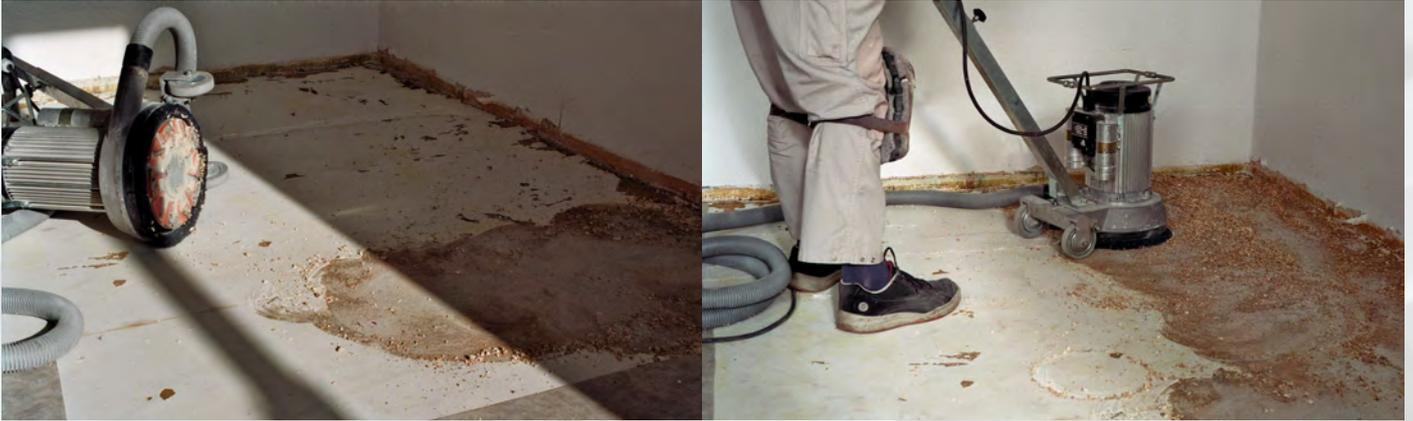
PKD-Frässcheibe 250 NT mit Stützsegmenten: Entfernen eines CV-Restbelages inkl. Kleber
