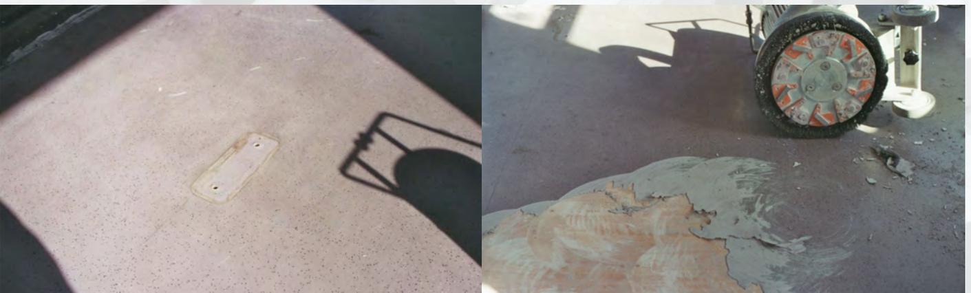
PKD-Fräuscheibe 250 NT mit Stützsegmenten: Entfernen eines 3 mm PVC-Belages von einem Holzboden (Wagonbau)
