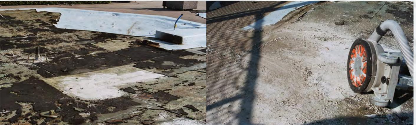
PKD-Fräuscheibe 250 NT mit Stützsegmenten: Entfernen von verklebter Schwimmbadfolie
